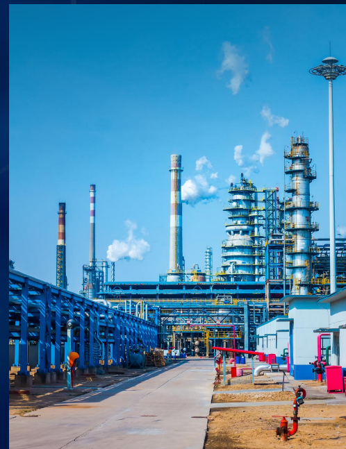
污水厂、食品、酿造、制药、钢铁、石油、电镀、印染等监测
